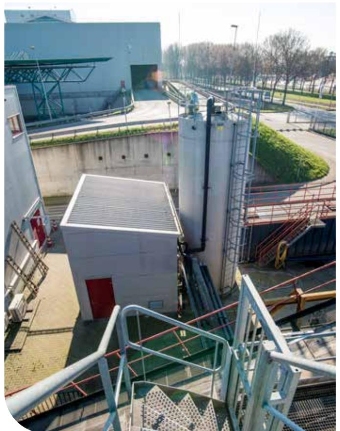
In de gasverwerkingsinstallatie wordt het biogas gedroogd, gereinigd en opgewerkt tot aardgaskwaliteit.
